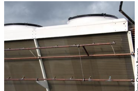
Der Spray-Betrieb der Rückkühler wird erst bei höheren Außenluft-Temperaturen aktiviert
