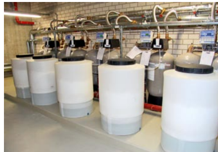
Wasseraufbereitung für den Spray-Betrieb der Rückkühler
