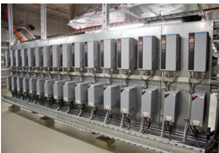
Je zwei Frequenzumrichter dienen zur Drehzahlregelung der 16 Rückkühler
