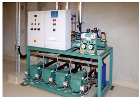
Verbundanlage Normal- und Tiefkühlung für ein Café
