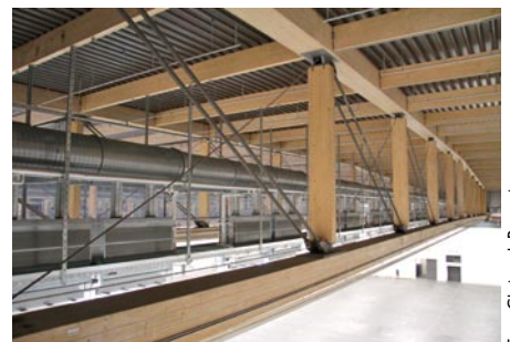
Insgesamt 288 ein- und zweiseitig ausblasende Induktionsgeräte für die Luftverteilung in der Halle
