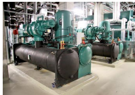
Zwei Schraubenverdichter mit je 1,2 MW Kälteleistung
