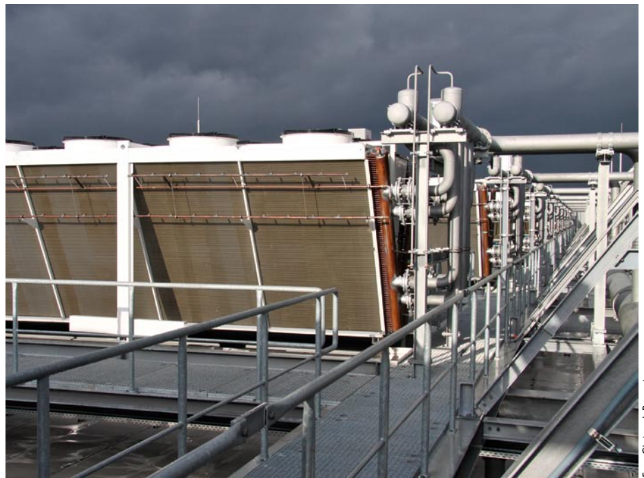
16 LU-VE Contardo-Rückkühler mit je 1,5 MW schmücken das Dach der Messehalle 11
