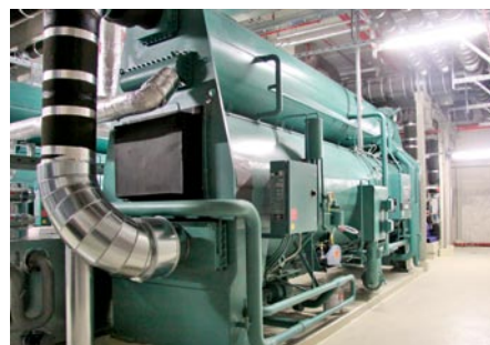
Absorberkältemaschinen mit 2,8 MW Kälteleistung
