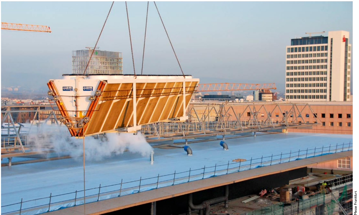
Einer der 16 Rückkühler wird auf das Dach der Halle II gehoben
