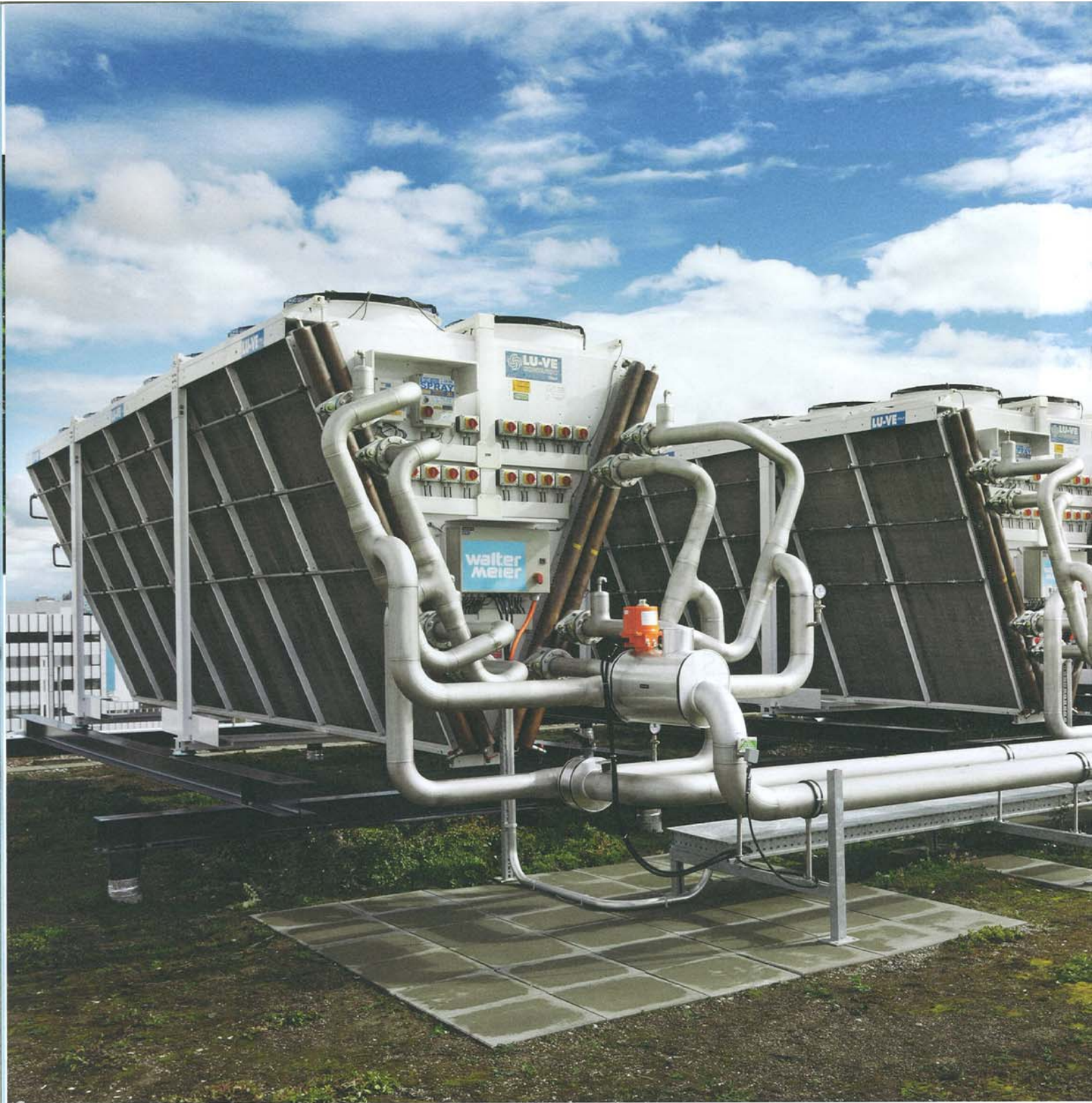
Aérefroidisseur adiabatique, puissance totale de 1950 kW. (Photos René Lamb)
