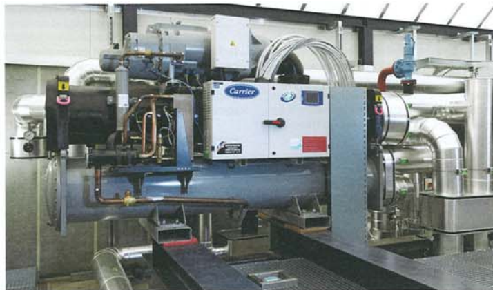
Générateur d'eau glacée Carrier 30XW562 de 550 kW.
