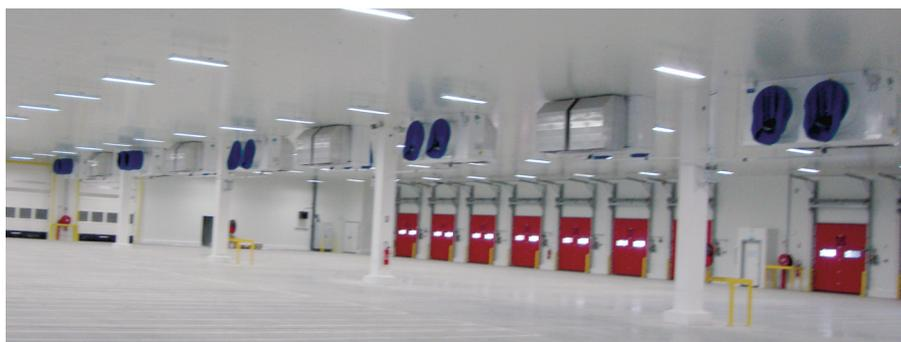
Normalkühlräume: 128 industrielle Glykol-Solekühler; eine Kältemaschine (NH<sub>3</sub>/Glykol-Plattenkühler) liefert das Kühlmedium für Normaltemperaturräume und Ladebereich.
