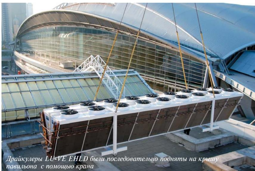
Драйкулеры LU-VE EHLD были последовательно подняты на крышу павильона с помощью крана
