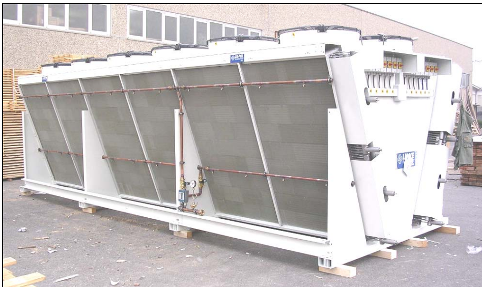
Fig. 4: Ein großer CO 2 Gaskühler, vor der Auslieferung aus der LU-VE Werkstatt.
